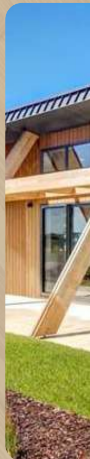
Casa de madera y paneles solares
